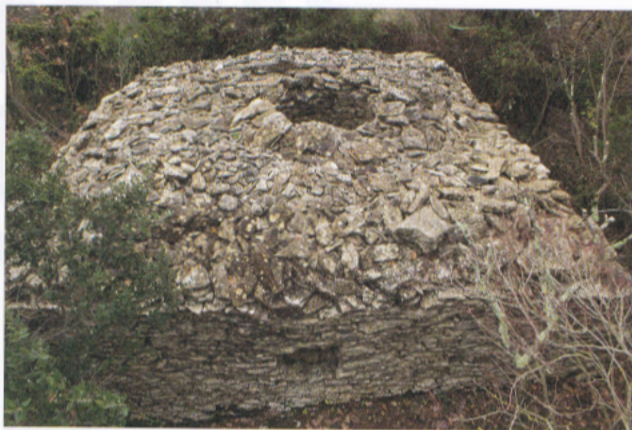
Fig. 7 - Four à chaux temporaire, Le Pâtis du Pla, commune de Gras. Vue en plongée
