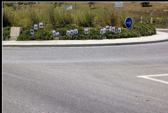
Rond-point sur la RD 86 à Saint-Montan
